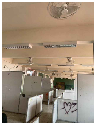
ภาพประกอบ : ห้องไฟฟ้า
