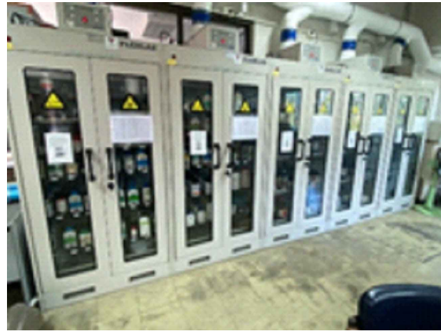
ตู้เก็บสารเคมี CS - ขนาด 0.58x1x2.19 ม. (รวมกล่องไฟ) จำนวน 5 ตู้
